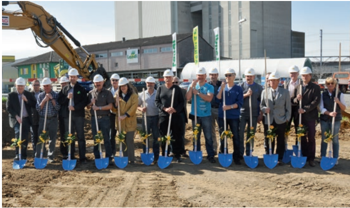
Les travaux sont lancés et l'inauguration du nouveau magasin est prévue pour octobre 2015.
