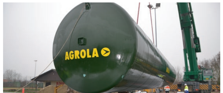
La citerne est déposée dans l'espace réservé à cet effet.
