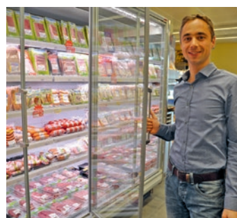
Les portes des frigos économisent de l'électricité.
