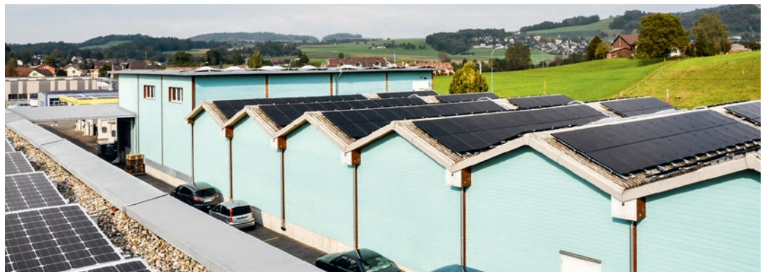
Solvatec SA a récemment installé des panneaux photovoltaïques sur les toits de la station-service, du TopShop et du magasin LANDI.
