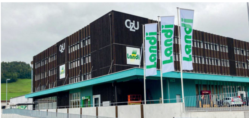
LANDI Schwyz a participé à la construction du « Geschäftszentrum Urmiberg ». Photo: LANDI Schwyz
