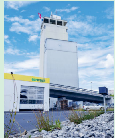
Un nouveau portique de lavage a été installé à Sempach Station. Photo: LANDI
