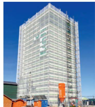
Le silo d'Orbe entouré d'échafaudages Photo : màd
