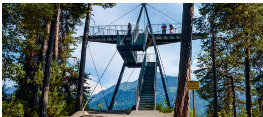
Cet édifice doit son nom à sa plate-forme triangulaire en mélèze. Il Spir surplombe le Rhin à 380 m de hauteur au-dessus du fleuve. Photo : Kathrin Schellenberg
