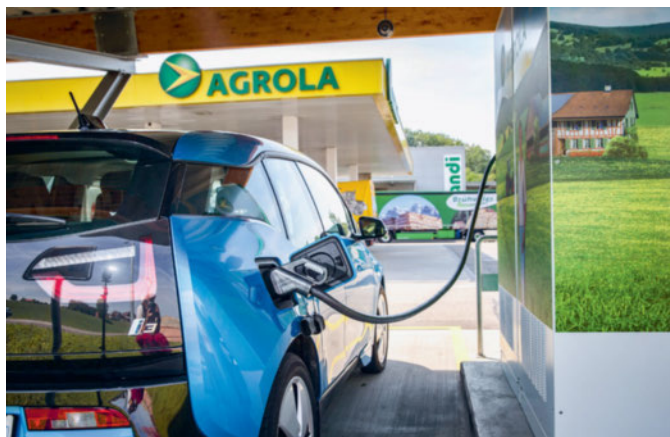
Station de recharge rapide pour véhicules électriques à Matzingen (TG). Photo: Esther Michel
