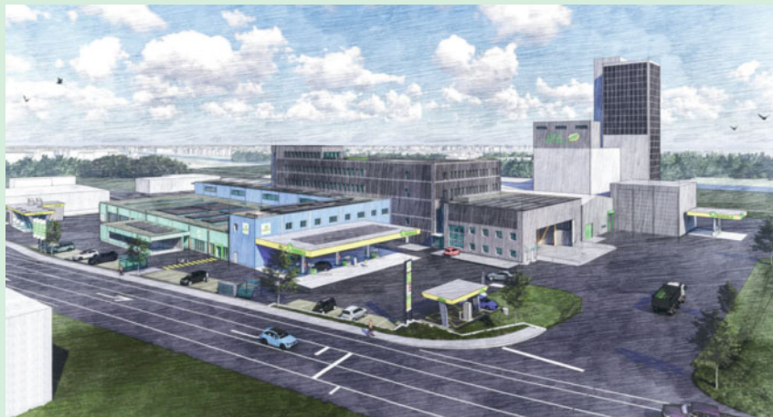
Les nouveaux bâtiments du centre de prestations Production végétale et de LANDI Lyssach.
