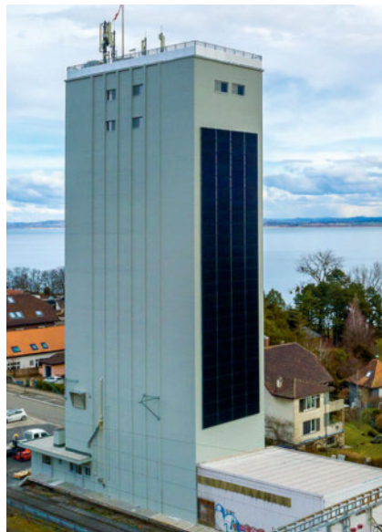
Le centre collecteur a été équipé d'une installation photovoltaïque en façade Photo: Nicolas Repond
