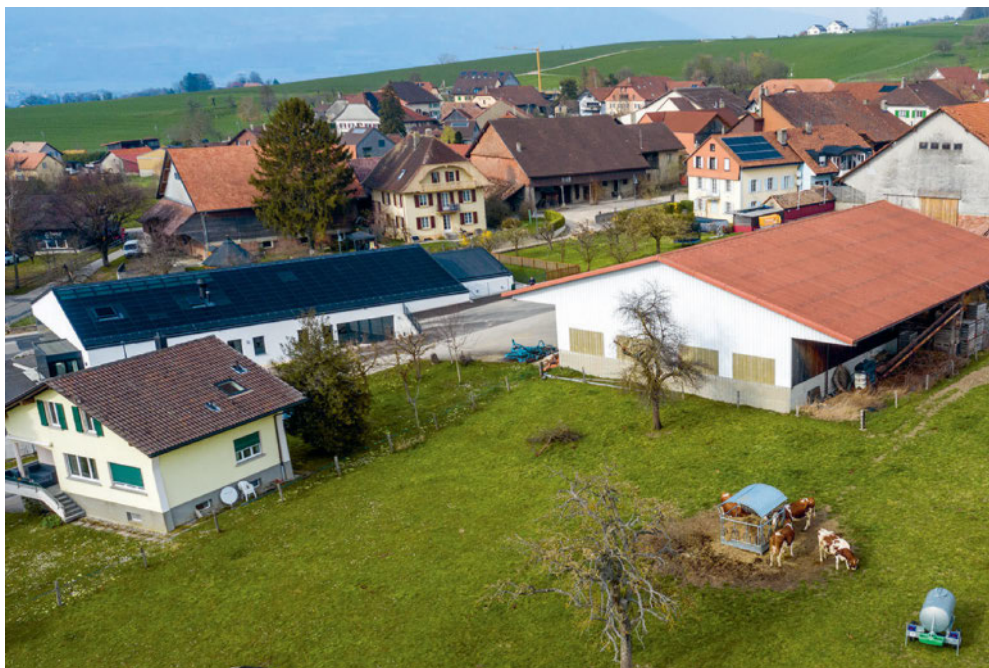
Le toit de la nouvelle ferme va être équipé de panneaux solaires.
