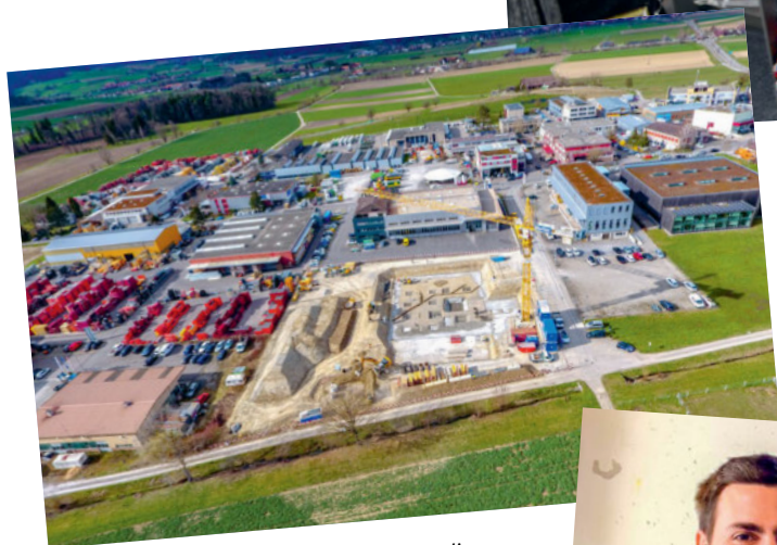
Les travaux de construction du nouvel atelier pour véhicules de Traveco à Ohringen (ZH) ont commencé au début du mois d'avril 2019. Ce complexe de 12 500 m 3 offrira près de trente nouveaux postes de travail et sera terminé à la fin du printemps 2020. Photo : mäd
