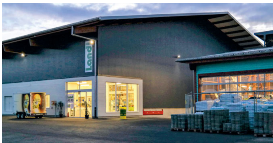
Le nouveau centre Agro de LANDI Luzern-West à Reiden. Photo: mäd
