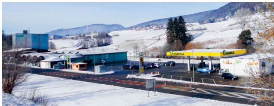
132 modules solaires ont été posés sur le toit de la station-service Agrola Photo: mäd
